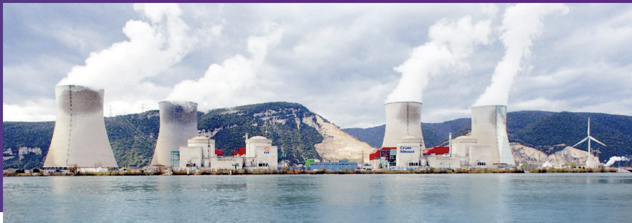
Centrale nucléaire de Cruas-Meyssac
